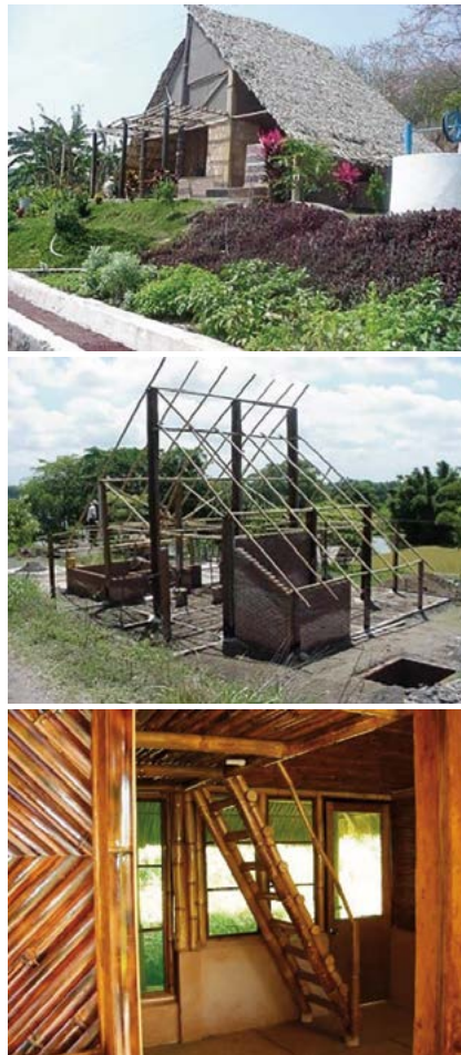
Figura 1. Casa terminada, estructura con materiales regionales y detalles con guadua colombiana tratada ( Guadua angustifolia ).
