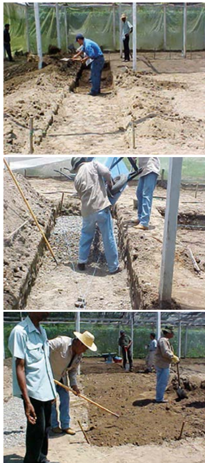
Figura 1. Preparación del terreno para la instalación del módulo.
