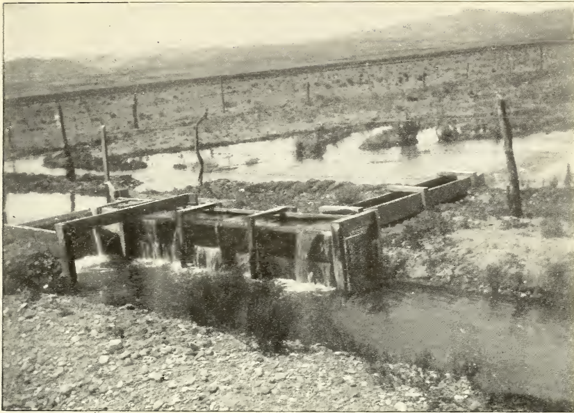
FIG. 1.—SPILL MEASURING WEIR.
