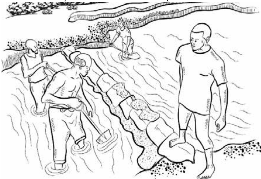
Barrage en sacs d'argile
