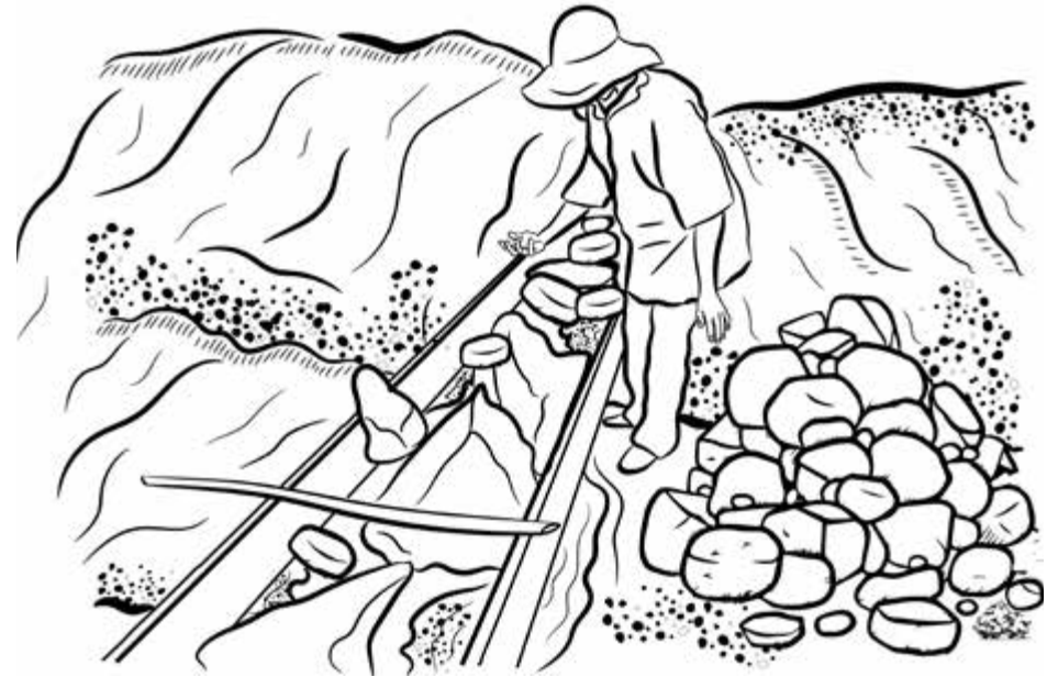
Construction d'un barrage en remblai de blocs de pierre en travers d'un cours d'eau
