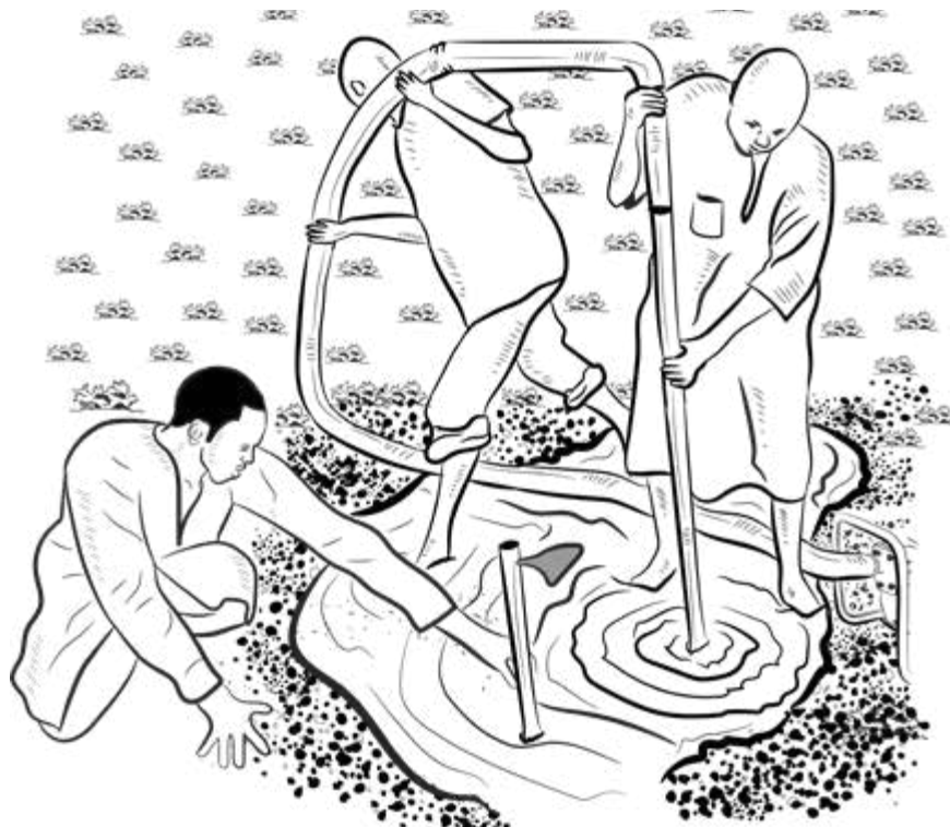
Étape 4 : Forage d'un puits tubulaire par lançage grâce à la pression de la pompe à eau
