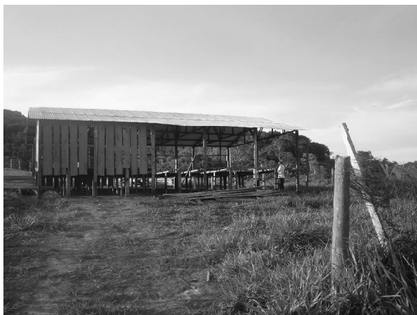
FIGURA 9 - Instalação com piso ripado e suspenso. Ilhéus, BA.
